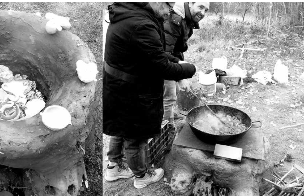
FIGURA 4: Horno primitivo. Secuencia de imágenes que muestran los procesos de construcción colectiva llevados a cabo por algunos de los miembros de Espacio Común Nalda. En la imagen central puede apreciarse cómo se introducen las piezas cerámicas dentro, y en la tercera cómo se aprovecha el calor residual para cocinar. Fotografías de Naiara Arrieta.
